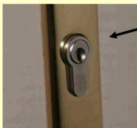
Cilindro reemplazable de forma normalizada con una llave (CA) específica
