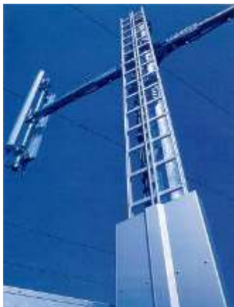
Figura 2-1: Antena GSM de estación base
