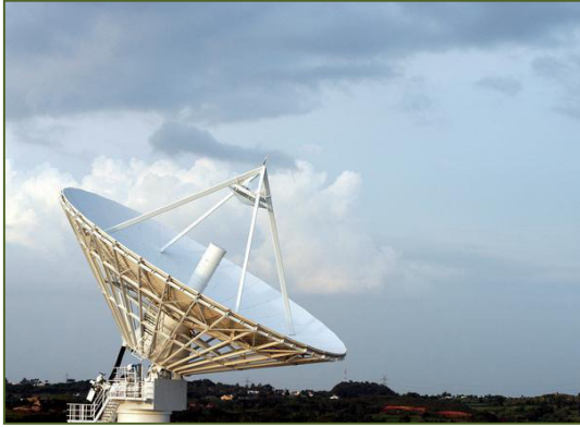
Figura 2-9: Antena parabólica 18 metros
