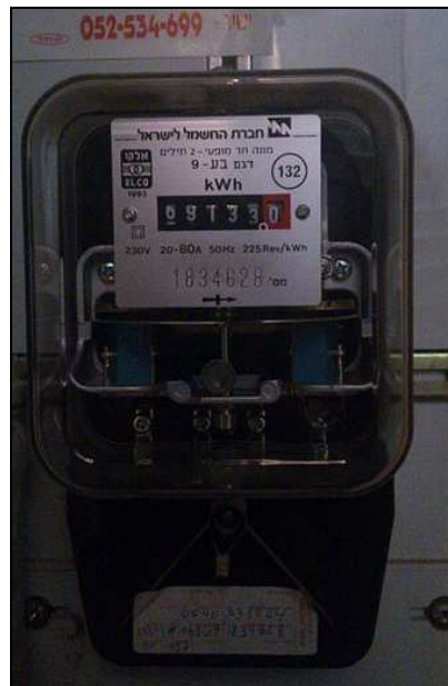
Figura 17: Contador electromecánico con sistema Feraris
