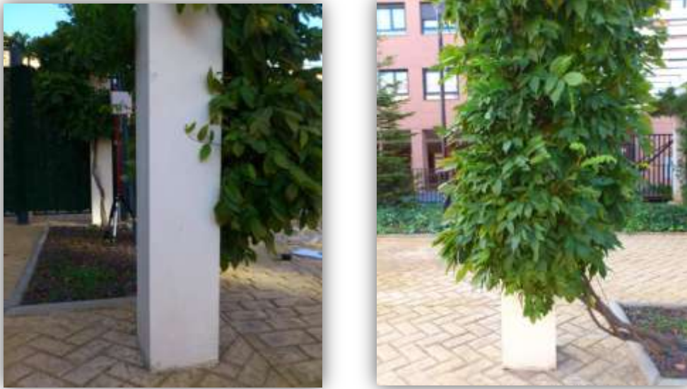
Figura 7.8.1 y 7.8.2: Diferentes vistas de la columna con enredadera
