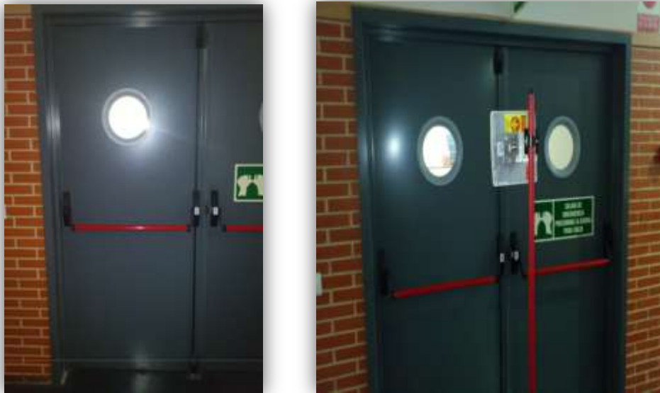
Figura 7.3.1 y 7.3.2: Diferentes vistas de la puerta metálica con ojo de buey
