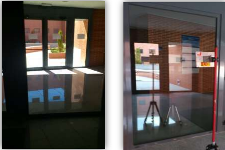
Figura 7.1.1 y 7.1.2: Diferentes vistas del cristal doble con cámara de aire
