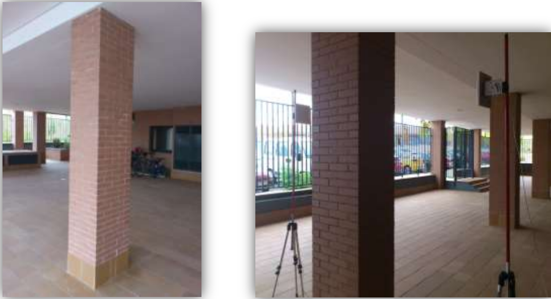
Figura 7.4.1 y 7.4.2: Diferentes vistas de la columna de ladrillo y hormigón
