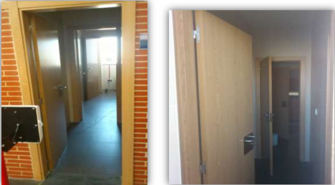
Figura 7.6.1 y 7.6.2: Diferentes vistas del pasillo con 3 puertas de madera
