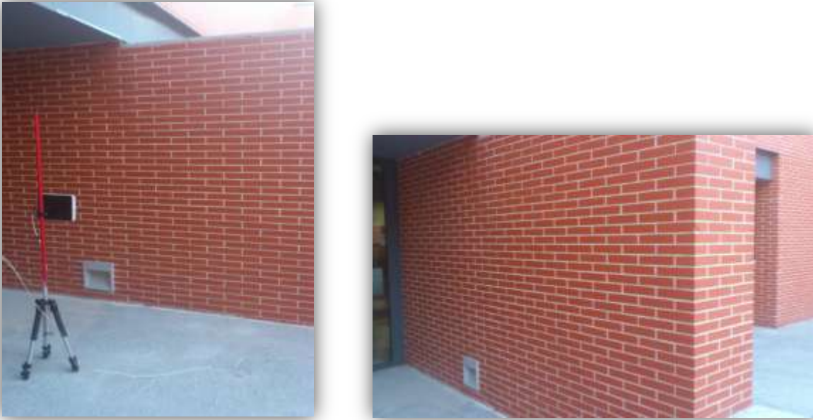
Figura 7.2.1 y 7.2.2: Diferentes vistas del muro de ladrillo y hormigón
