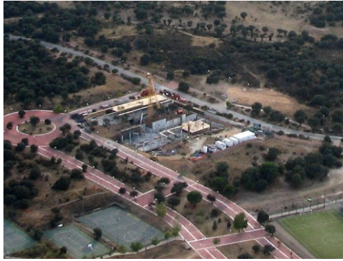
Figura 3-1 Fotografía aérea del entorno del edificio del CeDInt
