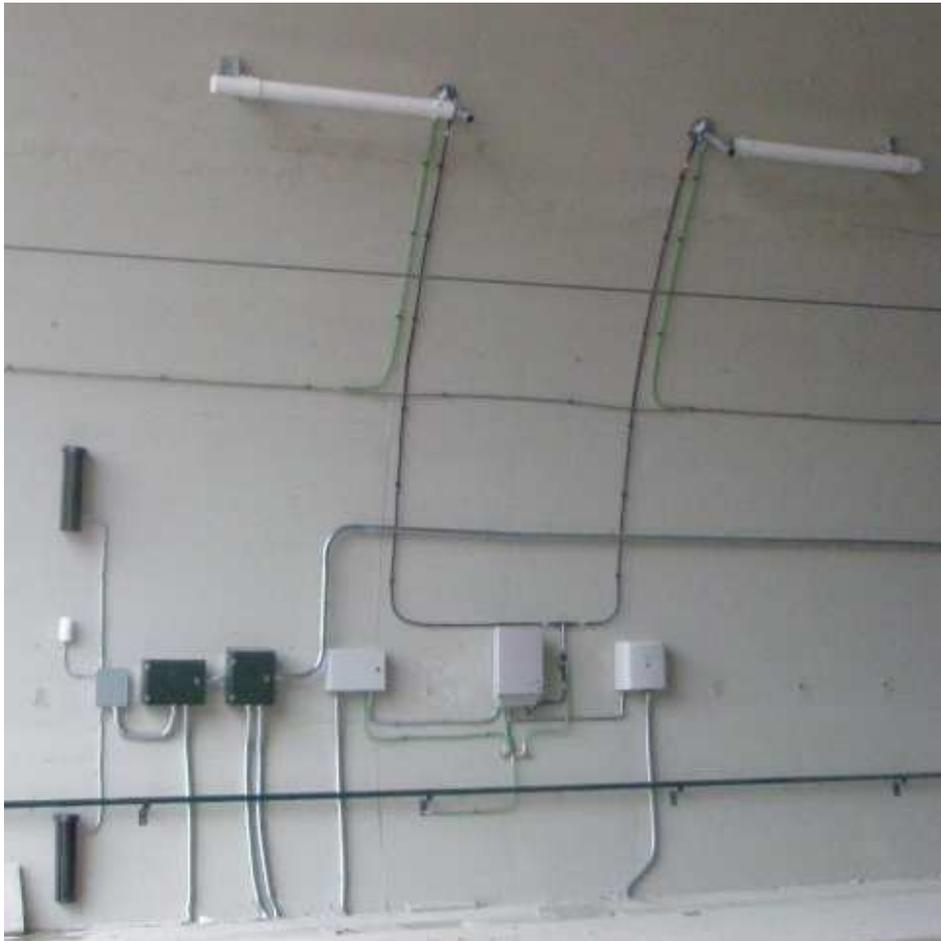
Repetidor de fibra óptica adosado al hastial de túnel. Se aprecia su ODF, su caja de alimentación, y otros sistemas como por ejemplo detectores de presencia etc. Las antenas son de polarización circular.
