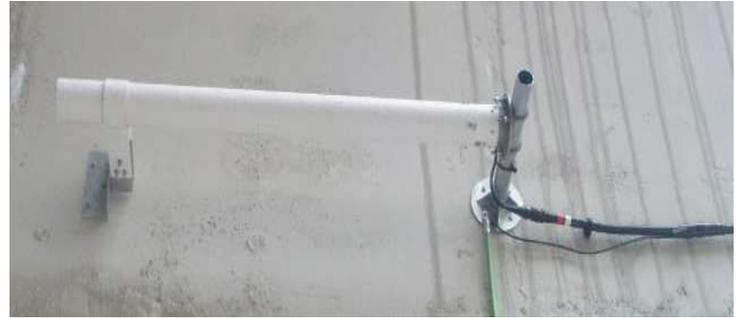
Antena de polarización circular de la BTS en boca de túnel.
