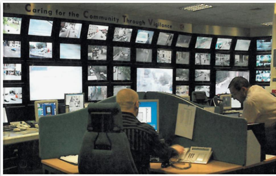
Figura 2-1: Sala de control de cámaras de video – seguridad en Bristol.
