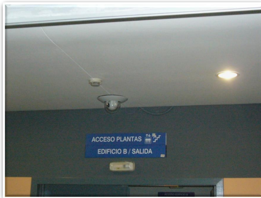
Figura 3-9: Hall EPS-UAM: Detalle Cámara IP.
