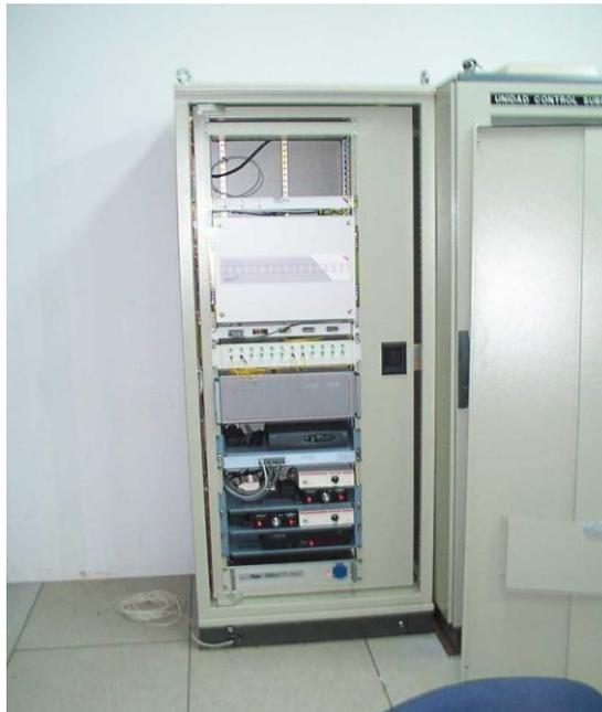
*Figura 12. Armario de comunicaciones de una subestación.*
