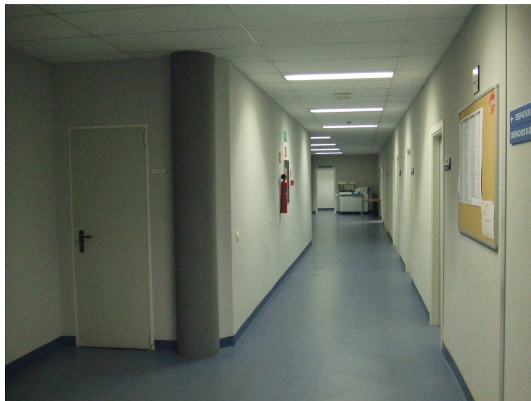
Figura 4-20: Imagen del pasillo de anchura variable situado en la planta 4 del edificio B de la EPS-UAM
