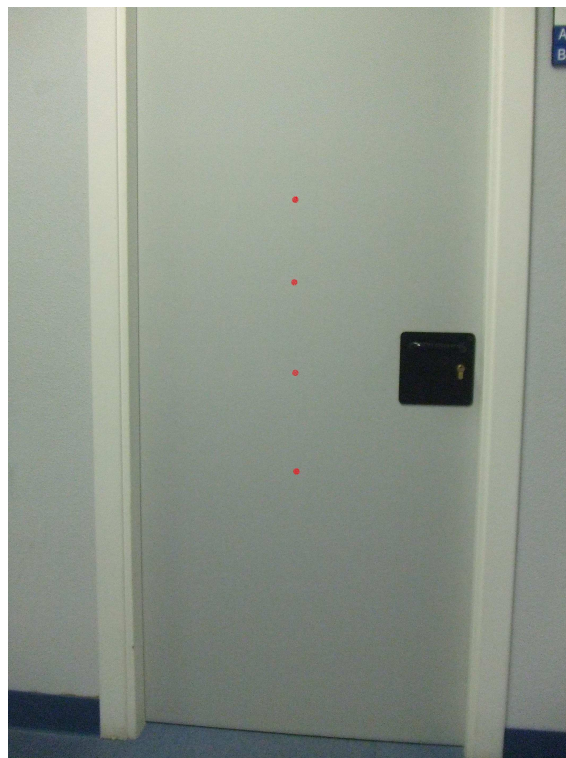
Figura 5-125: Imagen de los puntos aproximados donde se han realizado las medidas para una puerta de despacho del edificio B de la EPS-UAM.
