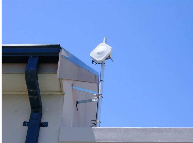
**Figura 2-22: Antena exterior de usuario**
