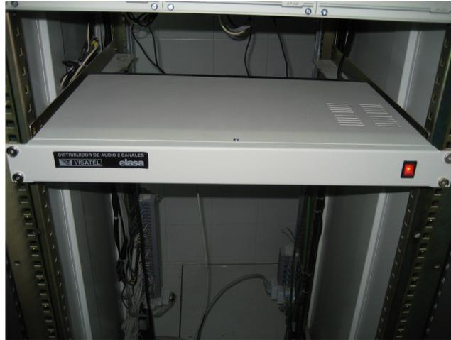
**Figura 72 Imagen del distribuidor de audio**
