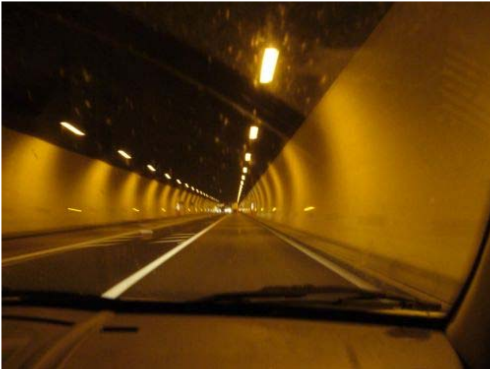
Figura 5.1 Túnel con varios carriles para la circulación de vehículos
