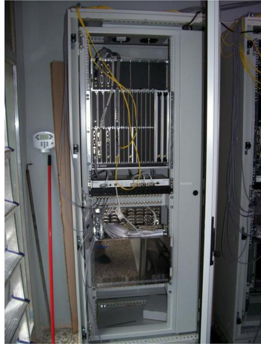
**Figura 13:** Armario en el que se encuentran los equipos multiplexor y SDH de SAGEM.
