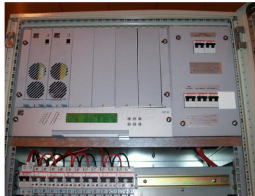
**Figura 15:** Maqueta del sistema de alimentación utilizada para las pruebas FAT.
