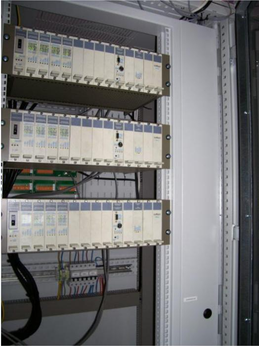
**Figura 12:** Armario conteniendo las Teleprotecciones contratadas marca DIMAT.
