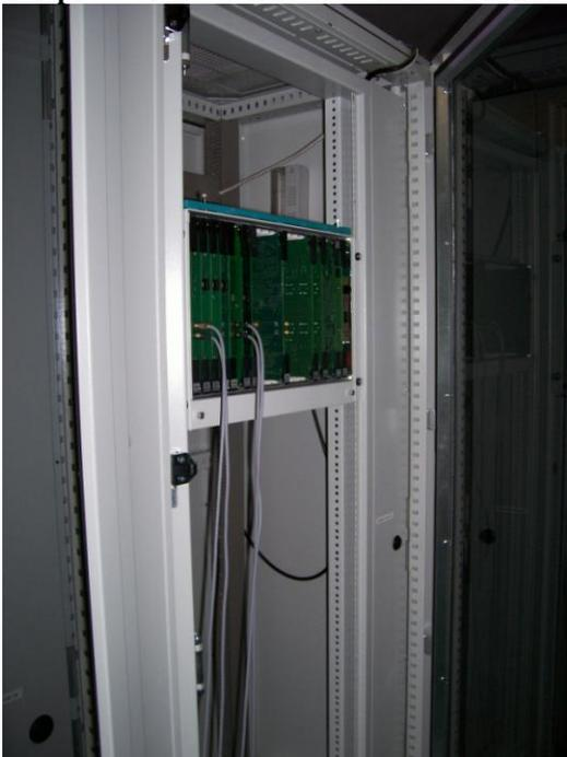
**Figura 14:** Armario que contiene la central telefónica y sus correspondientes tarjetas.
