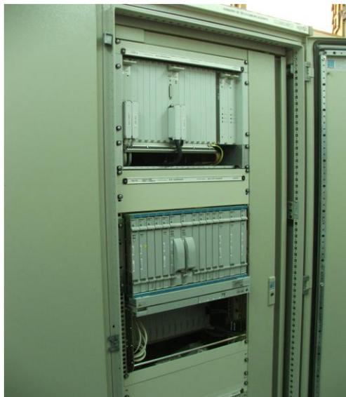
Figura 5: Equipo multiplexor SDH FOX515U de la marca ABB existente en la subestación de Judibana.
