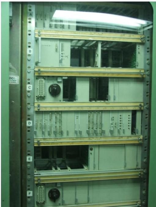
Figura 6: Teleprotecciones marca SIEMENS existentes en la subestación de Punto Fijo II.
